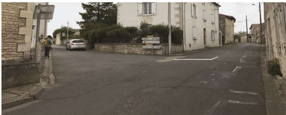
Un carrefour compliqué sans passage piétonnier identifié
