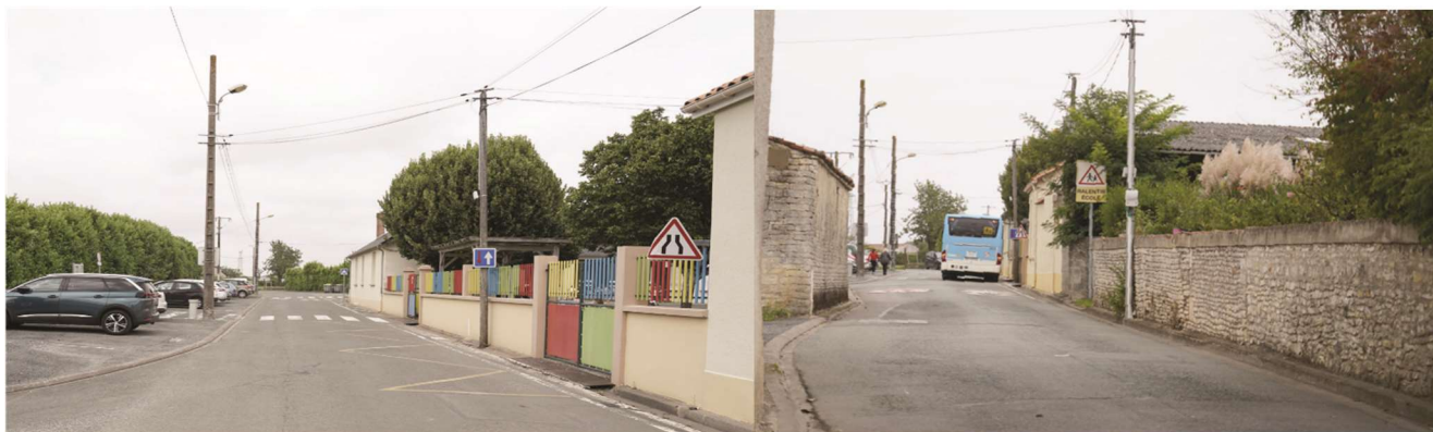
Réseaux aériens électriques et télécom sur la RD101
